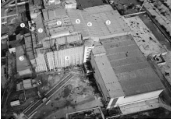
写真1 シェルタの外観構造
