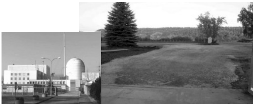
2010年10月にサイト解放したドイツのVAK発電所の解体前後の写真（VAK GmbH社資料から）
