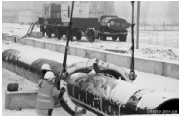
図1 NSC施設の基礎工事（参考文献2）
