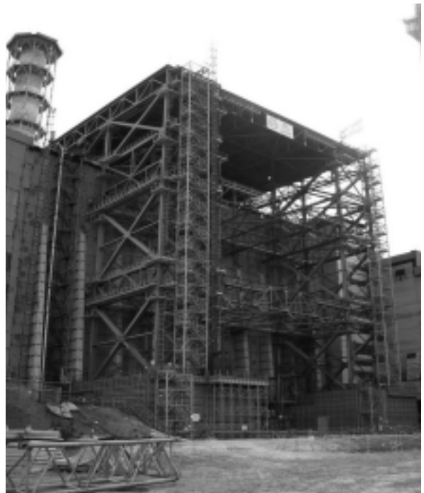
写真3 シェルタ西側ゾーンの安定化
